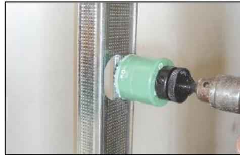
Las instalaciones, en especial griferías, cuadros de ducha, acoples, etc., deberán quedar firmes y sujetas en todo su recorrido, sin permitir movimientos por golpe de ariete, vibraciones o su accionamiento manual. Para ello se colocan refuerzos entre Montantes realizados con multilaminados fenólicos (Fig. 1), perfiles Solera o piezas de chapa BWG16 (Fig. 2), a los cuales se fijarán las cañerías con grapas omega.
