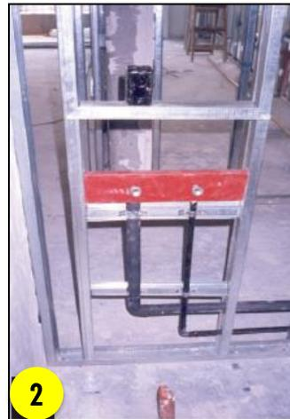
Se recomienda que todos los pases de cañerías queden sellados (con espuma poliuretánica o sellador hidrófugo) para evitar filtraciones dentro de las paredes y puentes acústicos.
